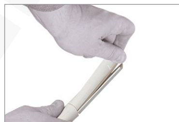
Efekt wzdłużnego nacinania izolacji
